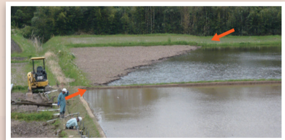
水田にも断層が発生
