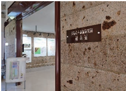
写真5 大谷石積の壁面
