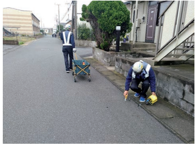
写真2 受振器を設置している様子
