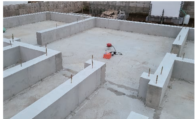
図7 基礎上での微動計測
