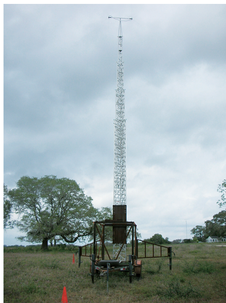
写真7 高さ20m程の観測車横のアンテナ塔
