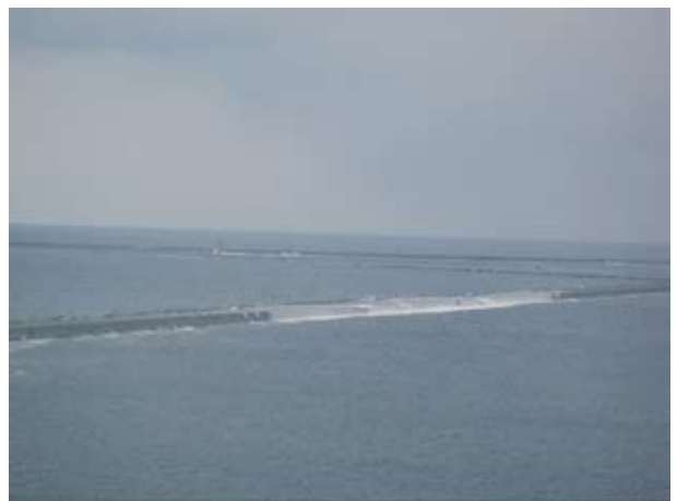
図2 同日15:52。北堤防の陸側より撮影。第一波が堤防を越える。
