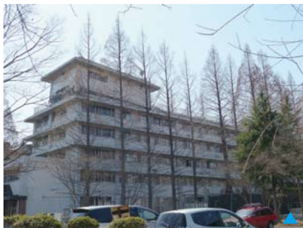
塔屋が斜めになっている東北アジア研究センターの建物。4月7日の余震で更に崩壊が進んだ。内部の階段、エレベータなども崩壊しており立入禁止。
