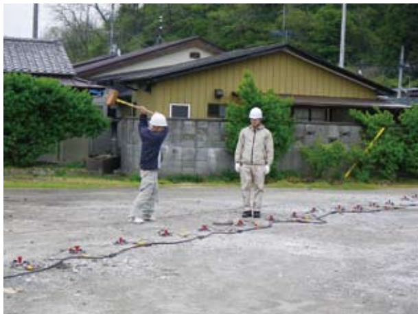
写真-4 表面波探査測定状況
