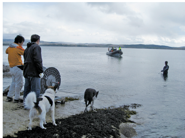
写真3 海底へのケーブル設置作業
