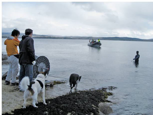
写真3 海底へのケーブル設置作業
