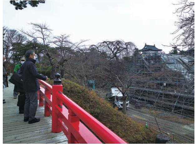
弘前城の石垣修理の様子
