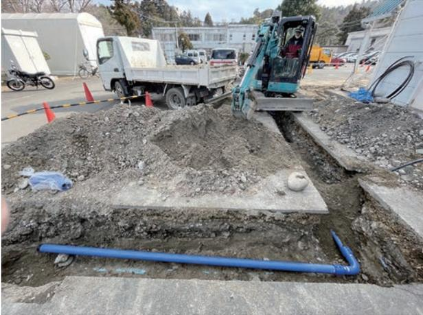
図5 東北大学構内の埋設管更新工事現場
