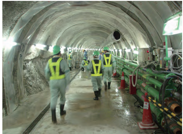
深度300mの水平坑道内の様子。カラーコーンの位置に受振器が埋設されている
