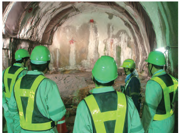
水平坑道の切羽
