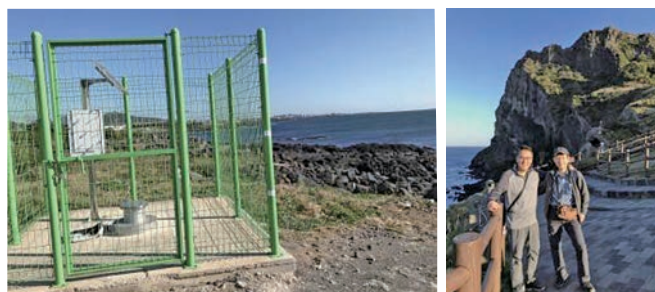
地下水観測施設
