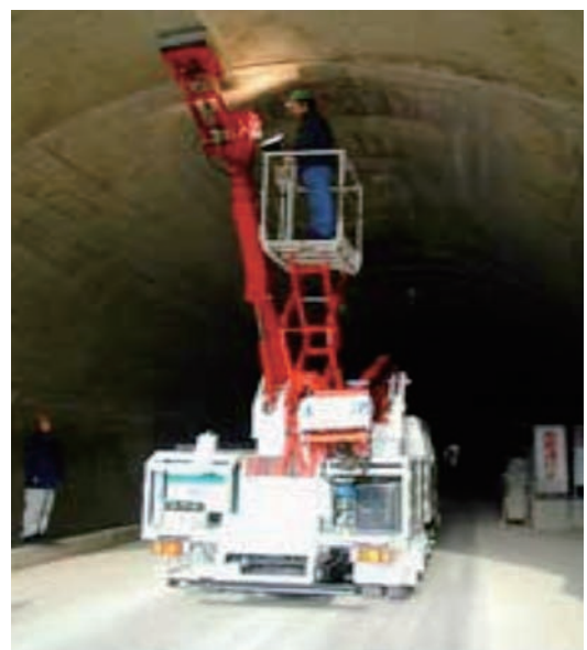
トンネル点検車RAPIDAS
