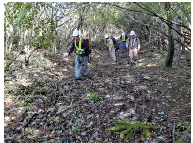
図2 富士山でのケーブル敷設作業
