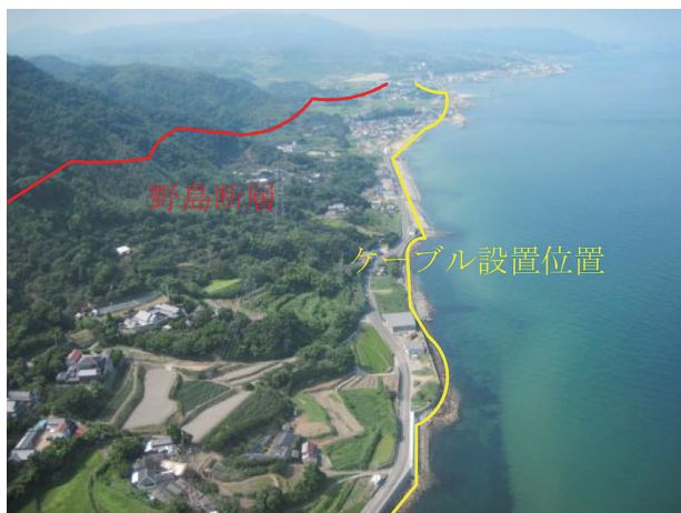
図1 北淡町のケーブル敷設位置
