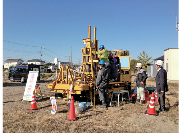
写真1 コーン貫入試験による液状化調査
