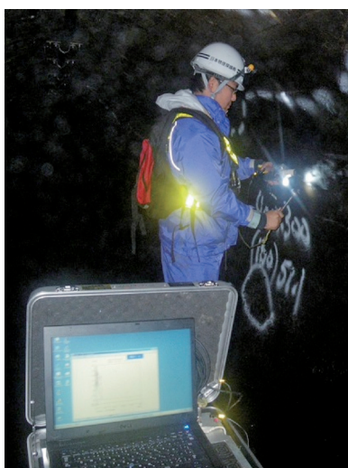
水路トンネル内でのソナライザ打音調査
