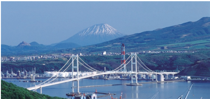
室蘭港に架かる白鳥大橋。はるかに羊蹄山を望む
