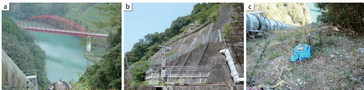
写真1 (a) 測線上流部(下流方向を臨む)、(b) 測線末端部の絶壁、(c) 斜面測線部
