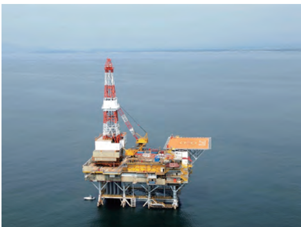
図5 新潟沖に浮かぶ岩船沖油ガス田。 奥に水平線のように見えるのが陸地。1983年の発見井では本邦初の海上VSPが実施された。1990年から生産を開始し、現在も稼働中。
