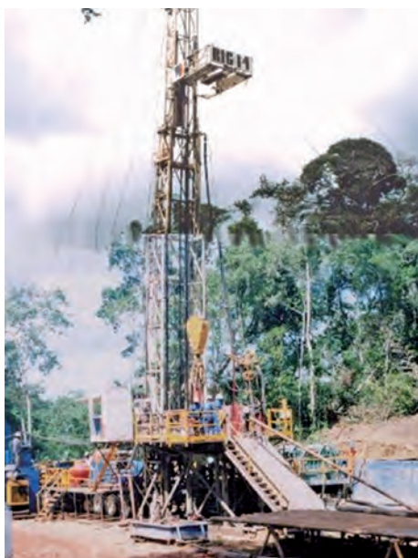
写真2 調査結果に基づいて掘削した新規油井
