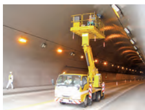
トンネルレーダ探査
