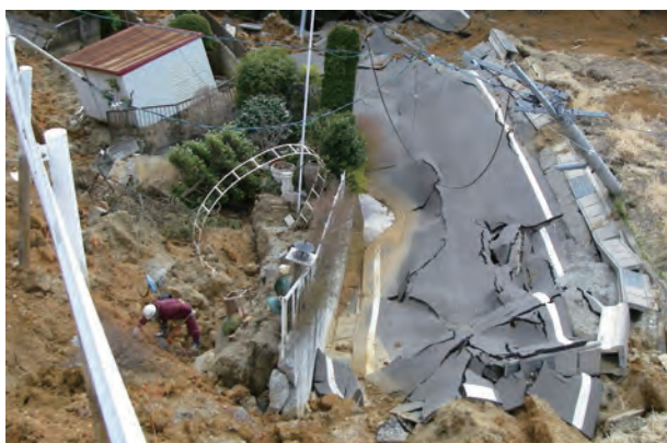
被災地での作業
