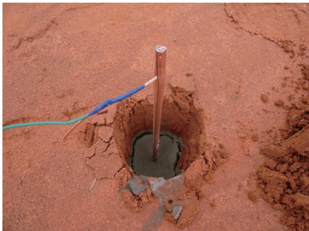
写真6 各電極にまいた接地抵抗低減材
