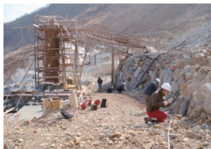
箱根大涌谷地熱地帯における電気探査
