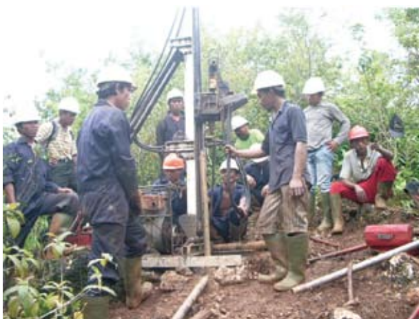
写真4 JACROによる作孔作業
