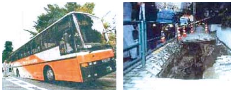
図-1 下水道の老朽化による陥没事故事例 (国土交通省ホームページより)
