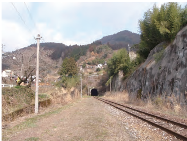
写真2 釈迦岳トンネル筑前岩屋方坑口
